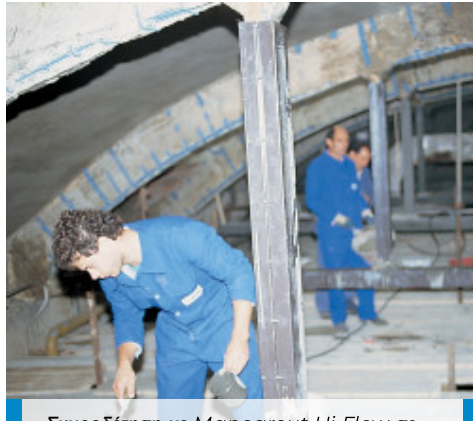
Σκυροδέτηση με Mapegrout Hi Flow σε μεταλλικό καλούπι
